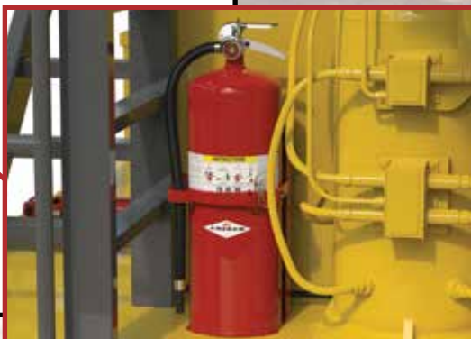
Extintor de Alto Fluxo
