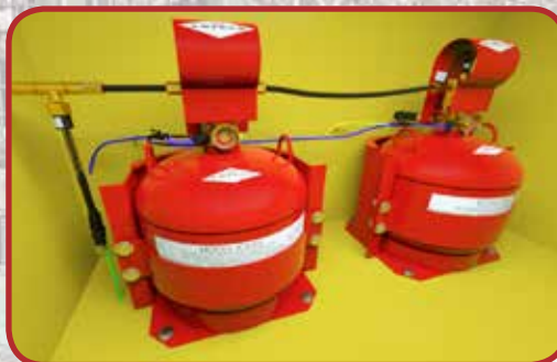
Cilindros de Agente Químico Seco - ICE
