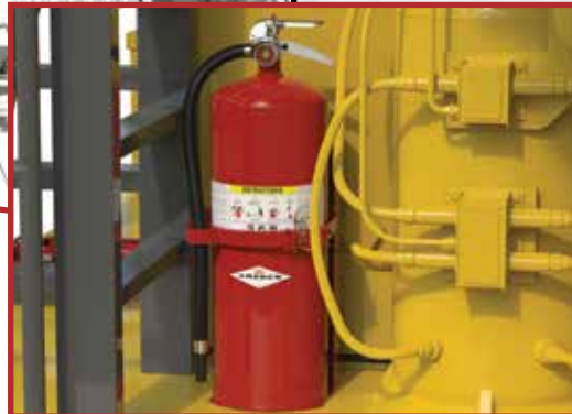
Extintor de Alto Flujo
